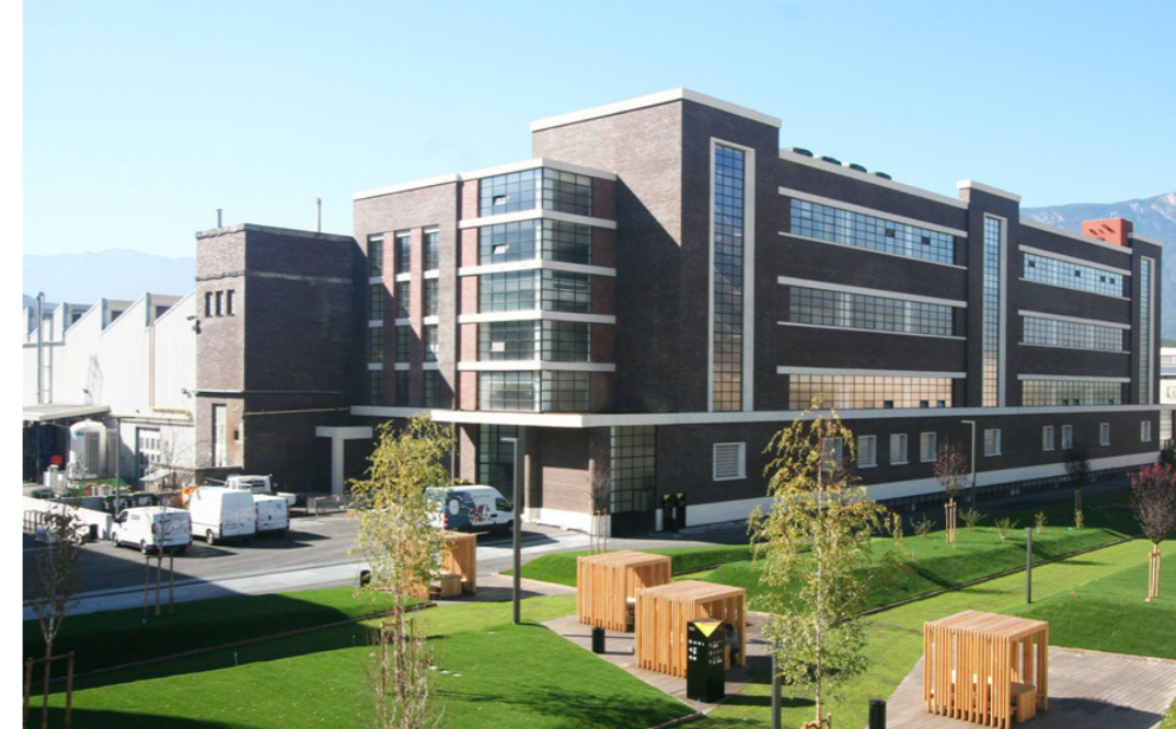
NOI Techpark, l'imponente nuovo quartiere di 120mila metri quadrati, di proprietà della Provincia di Bolzano, con certificazione LEED Gold
