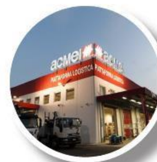
BARI PIATTAFORMA LOGISTICA S.P. Bari-Modugno-Toritto 73-74/A
