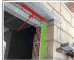
Dettaglio per la predisposizione della soluzione dei ponti termici amo scala
