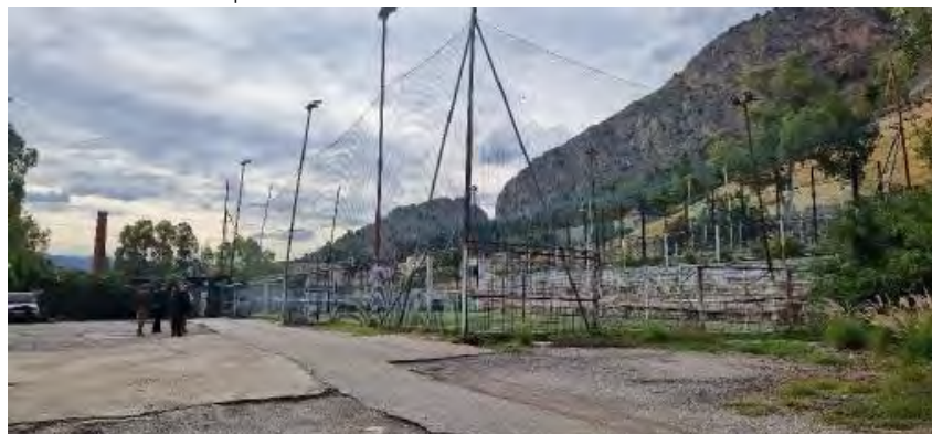
Veduta comparto lato Monte
