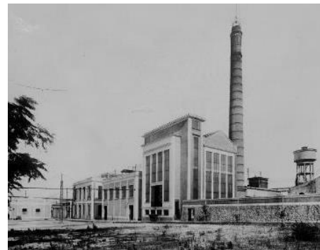
Vista della Centrale Termoelettrica - 1929
