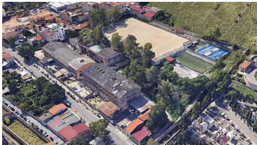
Veduta aerea comparto lato Monte
